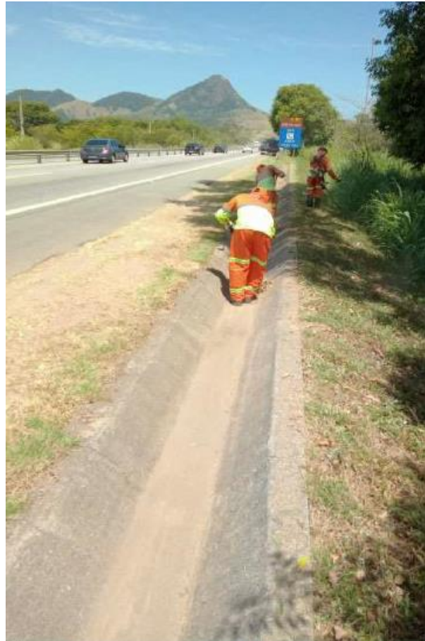
Figura 6.7 ViaLagos - Limpeza de Caneleta
