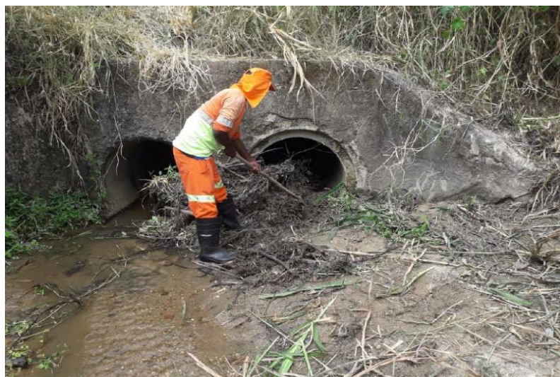
Figura 6.8 ViaLagos - Limpeza de bueiro
