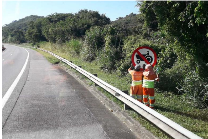
Figura 6.4 ViaLagos - Limpeza de Placa
