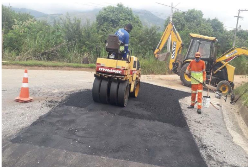
Figura 6.2 ViaLagos - Acostamento Km 10+000
