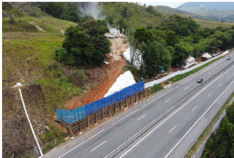
Figura 6.10 ViaLagos - Recuperação de talude
