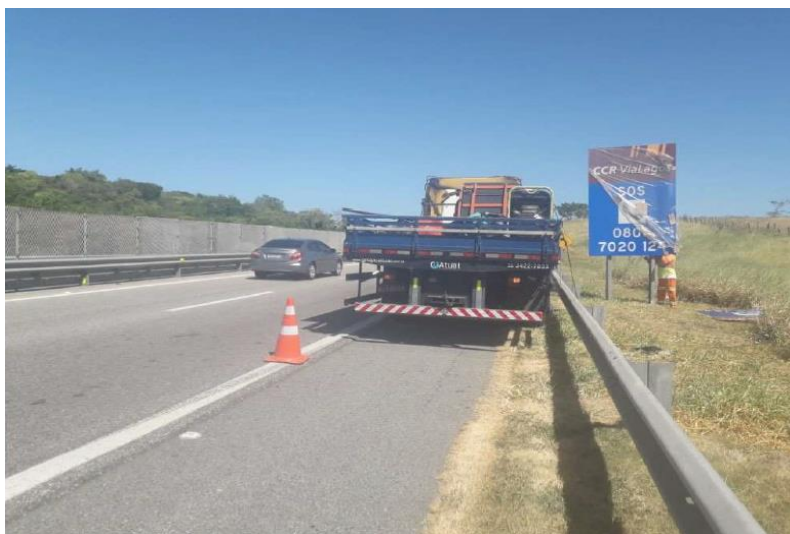
Figura 6.3 ViaLagos - Substituição de placa
